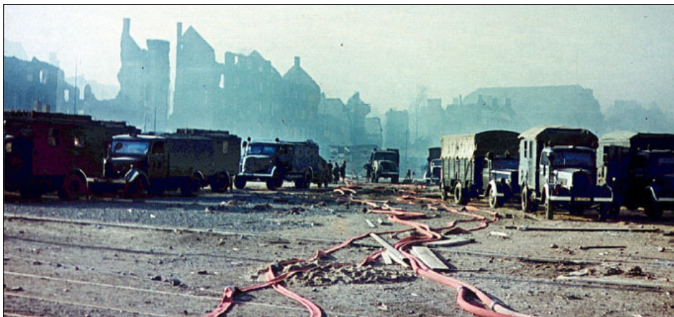
Kaum eine Chance im Inferno: Die Feuerwehr im Dauereinsatz am Morgen nach dem verheerenden Angriff auf Kassel. Friedrichplatz. FOTOS: STADTARCHIV
