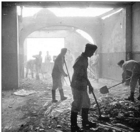
Aufräumarbeiten bei Henschel: Das bislang unveröffentlichte Foto stammt aus dem Nachlass eines Henschel-Direktors und entstand am 9. Oktober 1943. QUELLE: STADTMUSEUM
