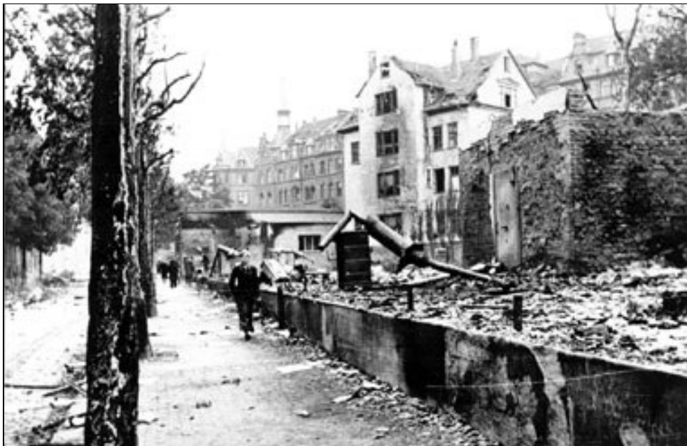
Trümmerfeld: Die Henschelstraße mit Blickrichtung Holländischer Platz nach dem Angriff vom 3. Oktober.
