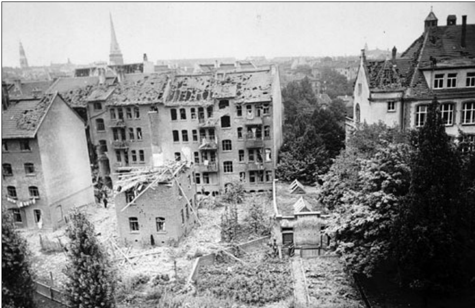
Die ersten schweren Treffer: An der Gräfestraße in Wehlheiden starben im August 1940 zwei Menschen, mehrere Häuser wurden stark beschädigt. FOTOS: STADTARCHIV
